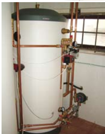
Katilinėje sumontuoti šilumos siurblio sistemos įrenginiai – 400 l talpos karšto vandens šildytuvas ir 400 l akumuliacinė talpa.
