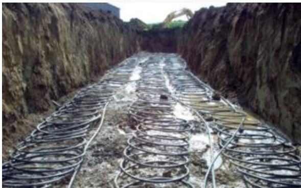
7 pav. Kairėje viršuje - supaprastinta šilumos siurblio schema ir darbinis ciklas: 1-kondensatorius, 2-vožtuvas, 3-garintuvas, 4-kompresorius. Kairėje apačioje – šilumos kolektorius. Dešinėje – šilumos siurblys.
